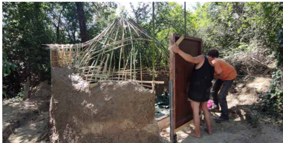
Hutte en terre - Chantier participatif dans un éco-lieu proche de Toulouse - Création d'habitats légers pour loger temporairement du public pour des stages liés à la permaculture, 2020
