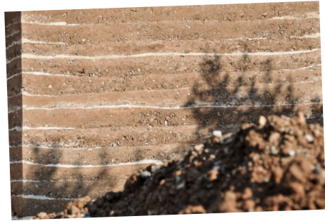
1) De la terre au mur, les strates des couches de terre et les irrégularités «erreur» dans le mur.
