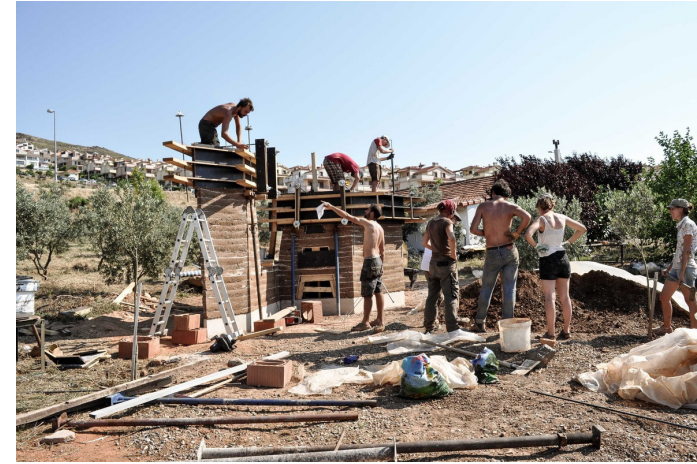
6) Travail en équipe, technique de construction en pisé.
