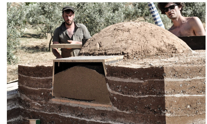
8) Projet en cours de réalisation
